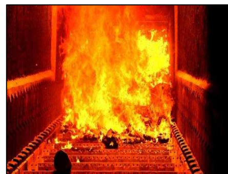
La grille du four de l'une des deux lignes d'incinération
